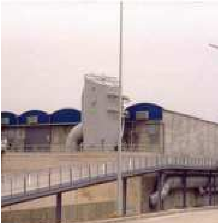
Compartimentos biofiltros y humidificadores
