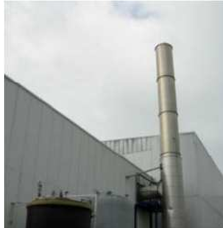
Chimenea de 25 m
