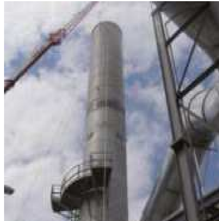
Chimenea de 37 m
