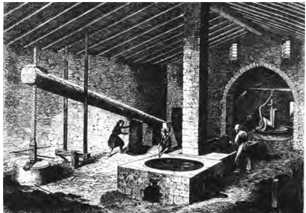
Tafona de Comasema. (Bunyola). Gravat de l'obra de l'Arxiduc Lluís Salvador. Les Balears descrites per la paraula i la imatge (1869)
